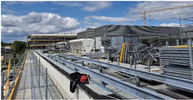
Nach außen sichtbar wurde der Abschluss der Dacharbeiten durch die Abrüstung der Technikzentrale.
