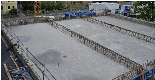
Arbeiten am Dach des Foyer-Neubaus
