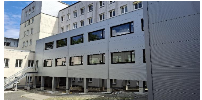
Der neue Verbindungsgang ist ein Stahlbau mit gedämmter Metallpaneel-Fassade.
