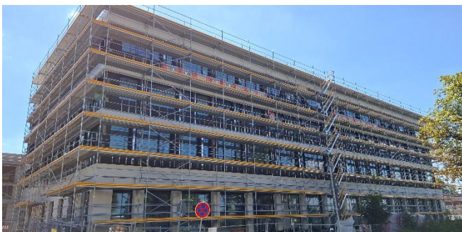
Betonelemente an der Fassade vom neuen Verwaltungsgebäude
