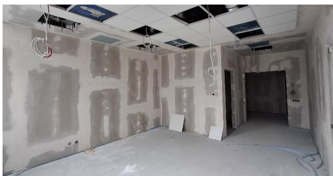
Blick in ein Zimmer mit Estrich, geschlossenen Wänden und fast fertiger Decke
