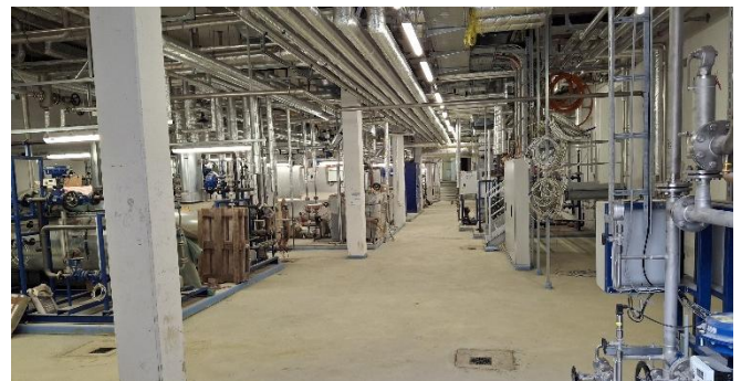
Die Heizungsanlage wird in den kommenden Wochen angeschlossen. Damit kann der Neubau in diesem Winter erstmals mit der fertiggestellten Heizungsanlage beheizt werden. Die funktionierende Wärmeversorgung schafft zugleich die Grundlage für weitere Inbetriebnahmen, die ab Frühjahr 2027 in größerem Umfang beginnen sollen.
