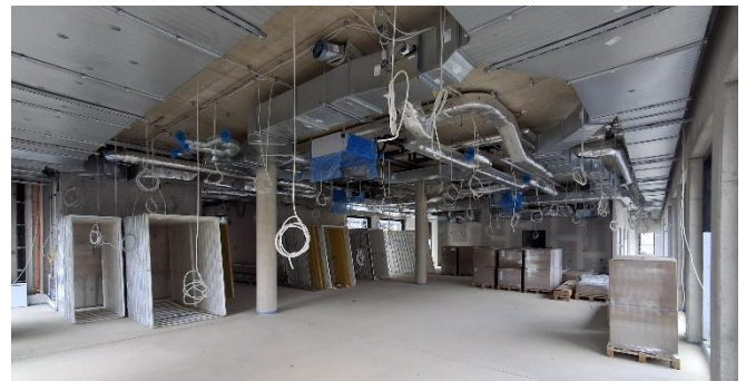
Blick in die neue Cafeteria, die aktuell als Zwischenlager für die zahlreichen Türzargen dient. Im gesamten Neubau werden derzeit Türzargen und teilweise bereits endständige Türen eingebaut.
