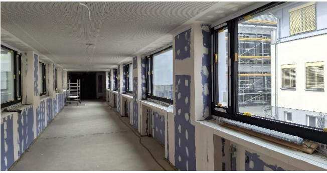
Der Verbindungsgang, über den man vom Bestandsbau in den Neubau gelangt.
