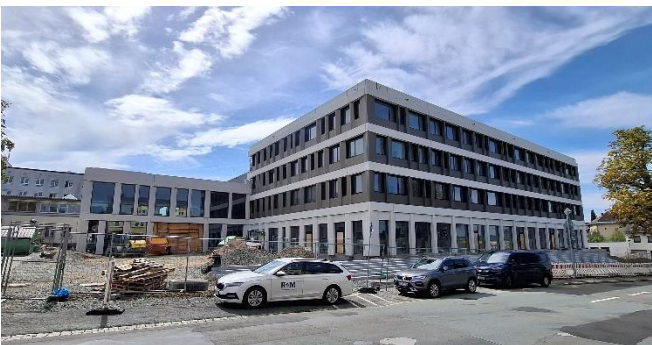
Die Fassadenarbeiten am Bauabschnitt 2 (neue Verwaltung) sind abgeschlossen. Von der Hofer Straße aus ist die künftige Gestalt des Neubaus nun deutlich sichtbar.
