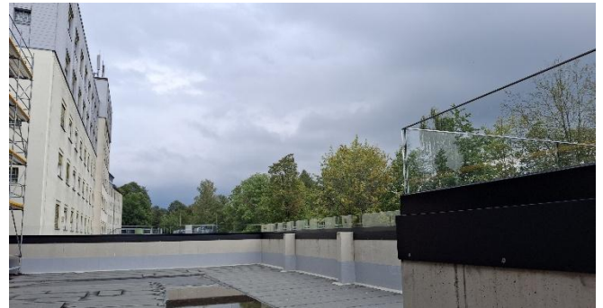
Auf der Mauerkrone der Liegendkrankenvorfahrt wurde das Glasgeländer montiert. Es dient dem erforderlichen Schallschutz.
