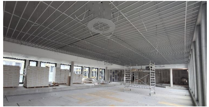
Im neuen Foyer werden derzeit die Deckeninstallationen von Trockenbauer, Elektriker, Lichtkünstler und Brandschützer angebracht.
