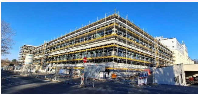
An der Fassade des 1. Bauabschnitts werden die letzten Betonfertigteile montiert.
