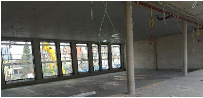
Der vorübergehende Zwischenboden im Foyer zum Einbau der Deckeninstallation
