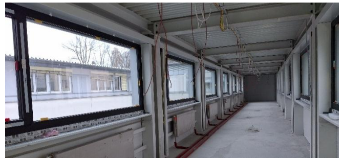
Im Verbindungsgang zum Bestandsbau wurden die Heizkörper und Elektroleitungen installiert.
