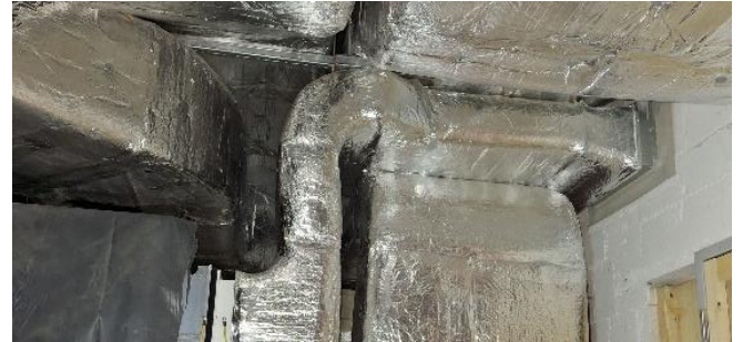
Die technischen Leitungen (Lüftung, Gas, Wasser) werden weiterhin aufwändig gedämmt.
