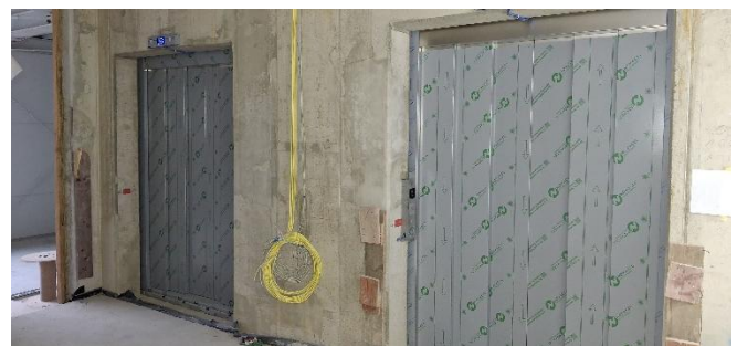
Es wurden vier Aufzüge eingebaut, von denen einer (gut geschützt) für den Bau genutzt wird.
