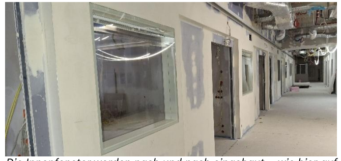
Die Innenfenster werden nach und nach eingebaut – wie hier auf der neuen Intensivstation.
