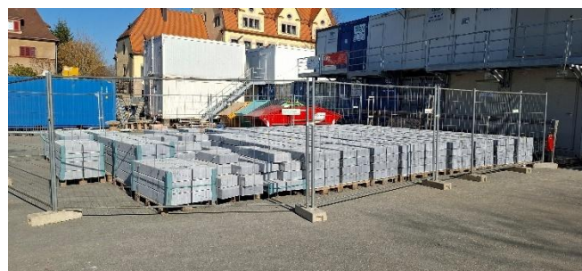
Mehr als 500 Betonstufen warten auf ihren Einsatz beim Bau der großen Eingangstreppe.
