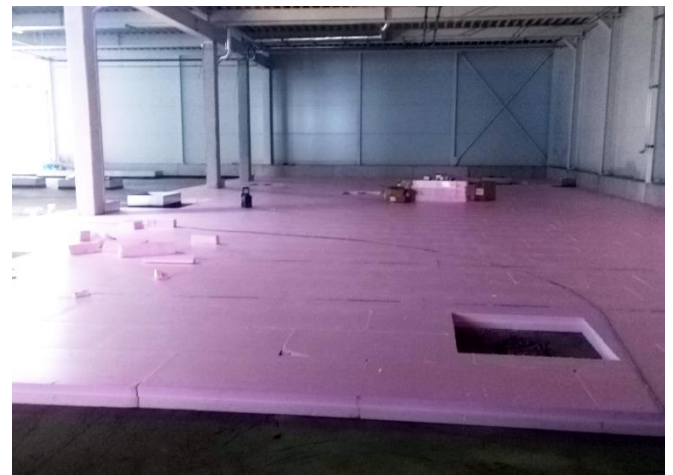
Dämmarbeiten in der Technikzentrale auf dem Dach des 1. BA
