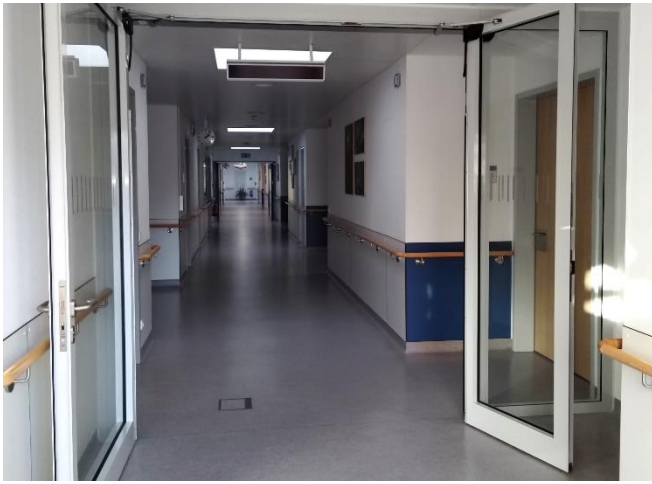
Neue Tür als Windfang in der UC-Station
