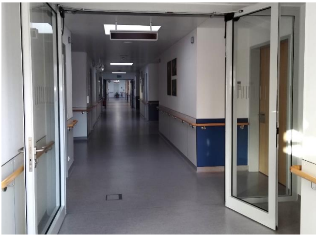
Neue Tür als Windfang in der UC-Station
