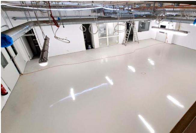
Halle für Anlieferungen im neuen Wirtschaftshof
