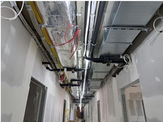
Leitungs-, Kabel- und Trassenführung
