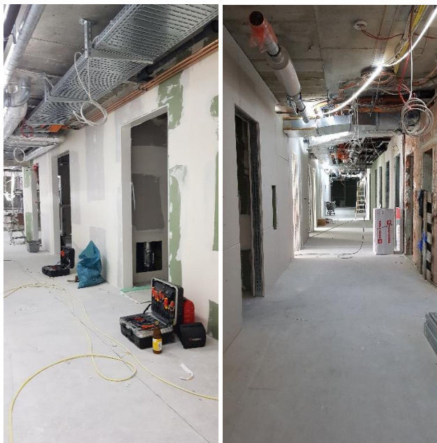
Trockenbau und Rohinstallationen
