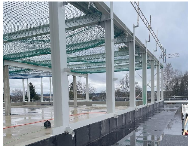
Errichtung der Technikzentrale auf dem Dach
