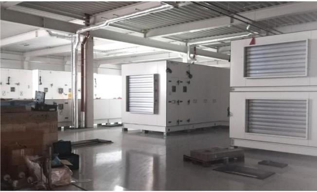
Technikzentrale mit Estrichboden und Lüftungsgeräten
