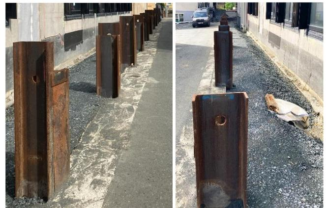
Abgeschlossene Hinterfüllarbeiten mit den noch zu ziehenden Verbau-Trägern
