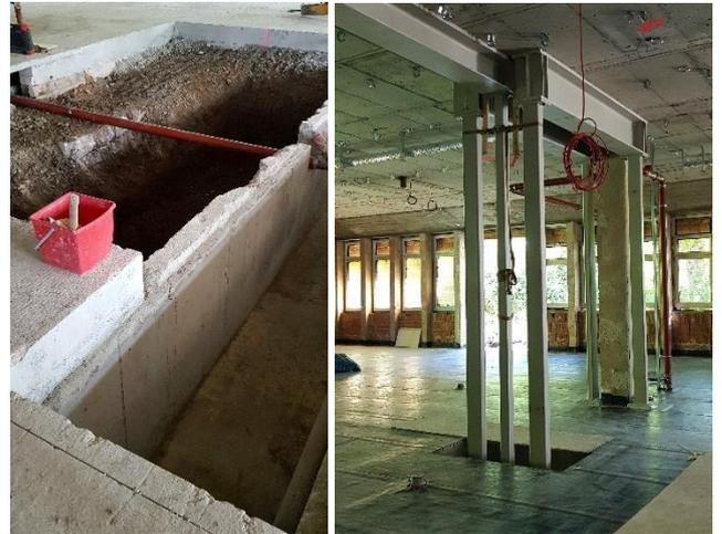
Fundamentaushub (links) für die dann eingesetzte Stahlstütze (rechts)
