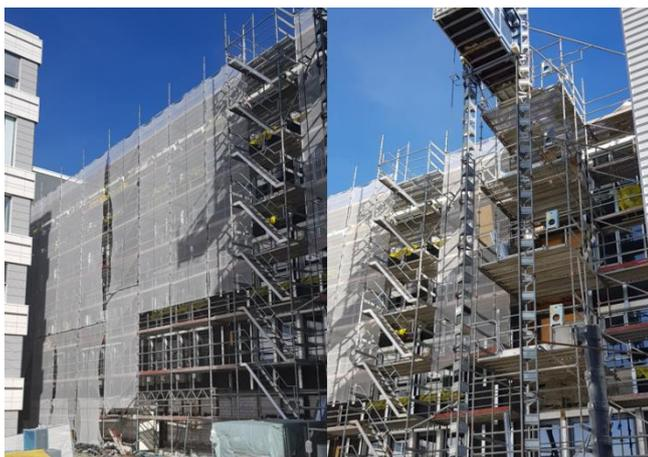
Laufende Gewerke sind Heizungs-, Lüftungs- und Sanitärinstallationen. Eingebaut sind auch die inneren Fensterrahmen. Vor Wintereinbruch soll zudem die Keramikfassade fertiggestellt sein.
