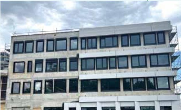
Durch die ersten montierten Betonfertigteile nimmt die Fassade des Neubaus weiter Gestalt an. Wenn die noch fehlenden Fenster eingebaut wurden, werden die Arbeiten der Betonfertigteile-Fassade wieder aufgenommen.
