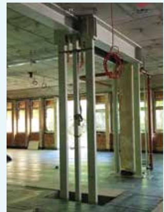
Fundamentaushub (links) für die dann eingesetzte Stahlstütze (rechts).
