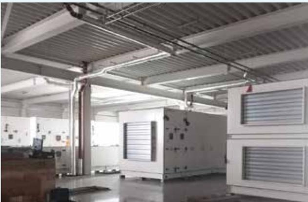
In der Technikzentrale wurde der Estrichboden verlegt und die Beschichtung aufgetragen. Im Anschluss daran wurden die Lüftungsgeräte in die Zentrale eingebracht.
