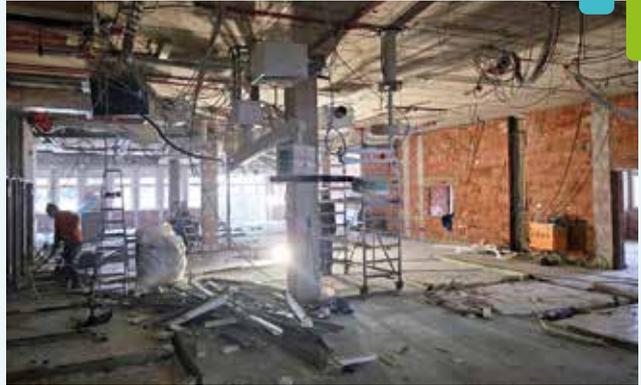
Hinter der Staubwand rund um die Radiologie wurden die Abbrucharbeiten zum größten Teil beendet. Neben den laufenden Trockenbauarbeiten wird parallel an Heizungs-, Lüftungs- und Sanitärinstallation gearbeitet.
