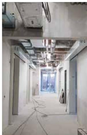
Trockenbauer schließen die Decken und Maler beschichten die Wände, sodass die Installateure mit der Fertiginstallation beginnen können.
