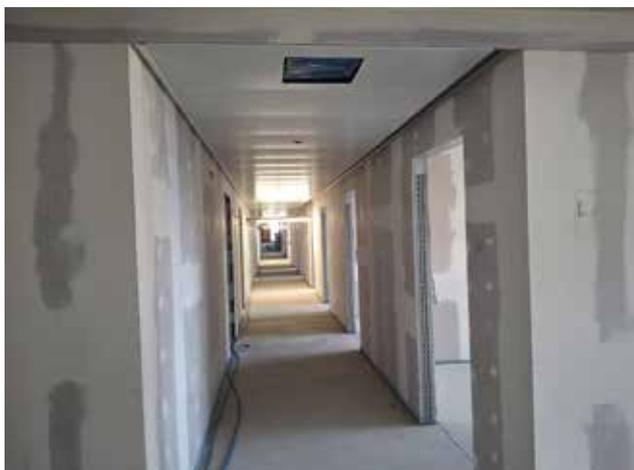
Die Trockenbauwände werden weiterhin nach und nach geschlossen. Die Ausführung erfolgt mit den entsprechenden Firmen, die Regelungs- und Messtechnik sowie Strom und Medienversorgungen einbringen.
